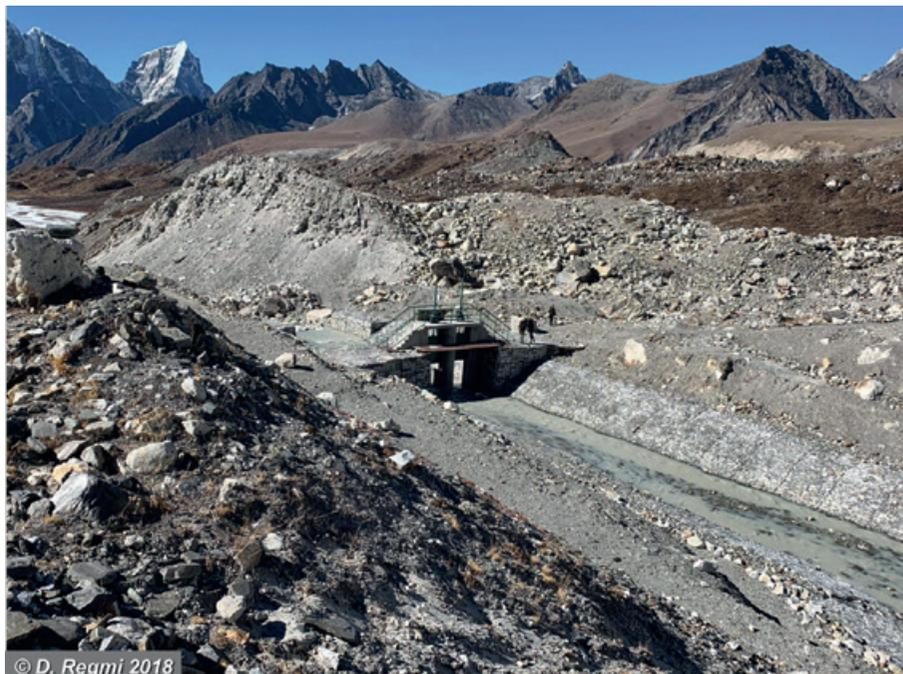
Figure 15. Canal de drainage du lac Imja ayant permis un abaissement du niveau d'eau de 3,4 m. Prise en période de basses eaux et de gel, la photo ne reflète pas les débits qui sont évacués en période de fonte des neiges et de mousson, et l'on peut donc s'interroger sur la durabilité de cet équipement à moyen terme. (Photo D. Regmi, décembre 2018)
